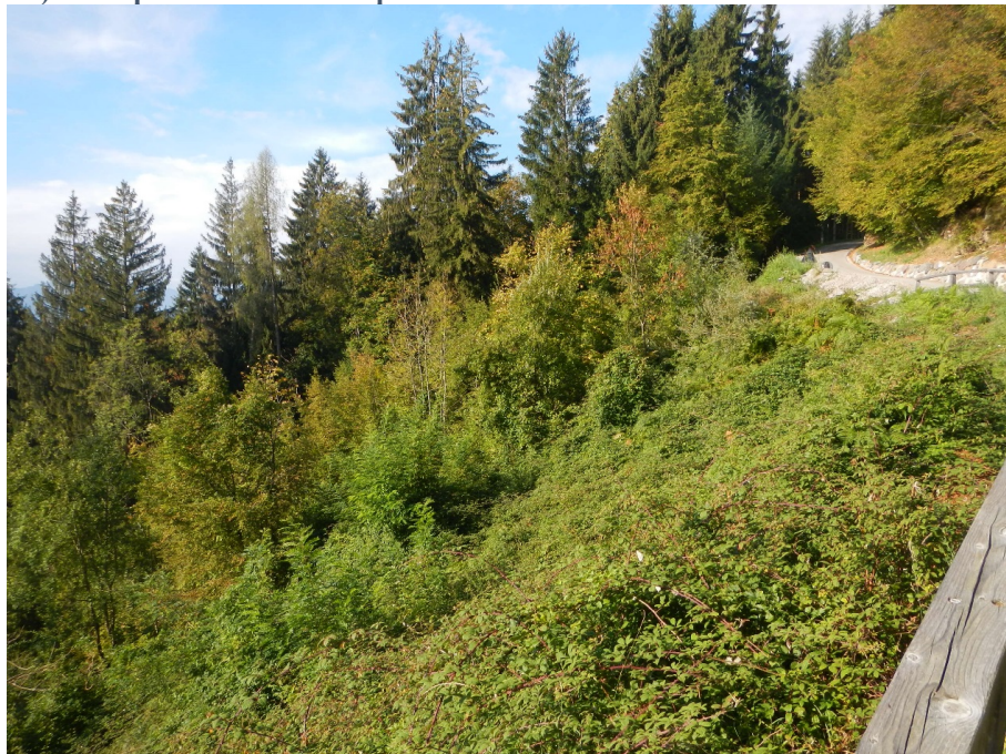
F10) Vista generale sul corpo franoso oggetto di sistemazione con tecniche di I.N. nei primi anni '2000, ora rinaturalizzato, con sovrastante viabilità principale di servizio.
