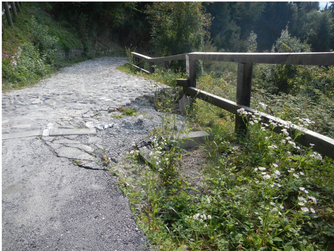
F9) Altro particolare sez. 7 e palizzata esistente.
